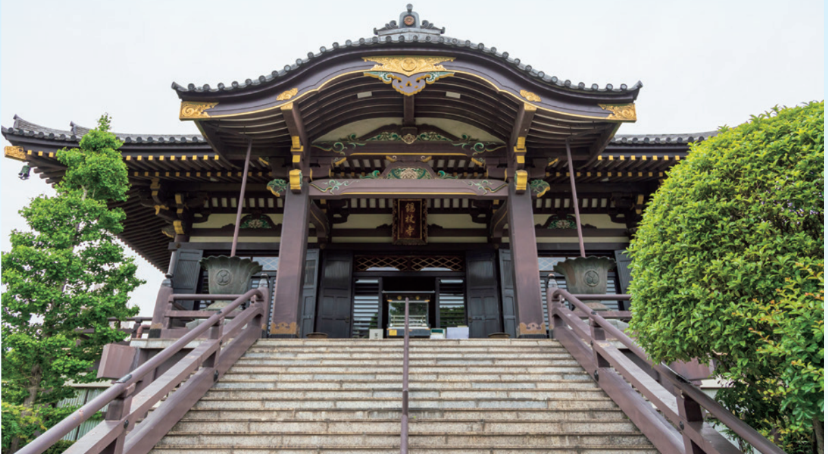
第35世政雄大和尚により発願され、第36世俊則大和尚の代、昭和50年10月10日落慶された鉄筋コンクリート2階建ての荘厳なる本堂。
